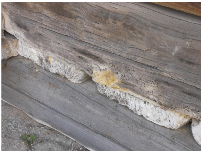
T.v. Utstickande golvplankor i bottenvåningen har vit svamppåväxt.
