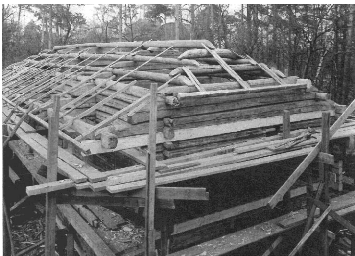
T.v. Bild från uppförandet av Yrsatorpsboden på 1920-talet på Skansen. Bilden visar takets åskonstruktion. Foto: Skansens arkiv, Röda Längan.
