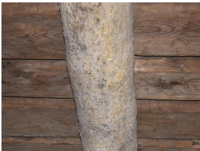
T.v. Bjälke i portlidret, mellanbjälklaget har samma påväxt som ovan.
